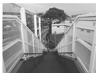
飯島橋手すり設置工事 (平25年)
